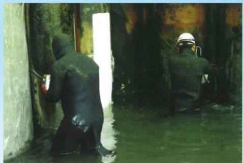
鋼管杭 防食補修施工例
