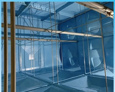
受水槽内の補修施工例
