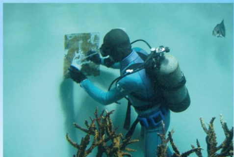
水族館水槽内防水塗装補修施工例
