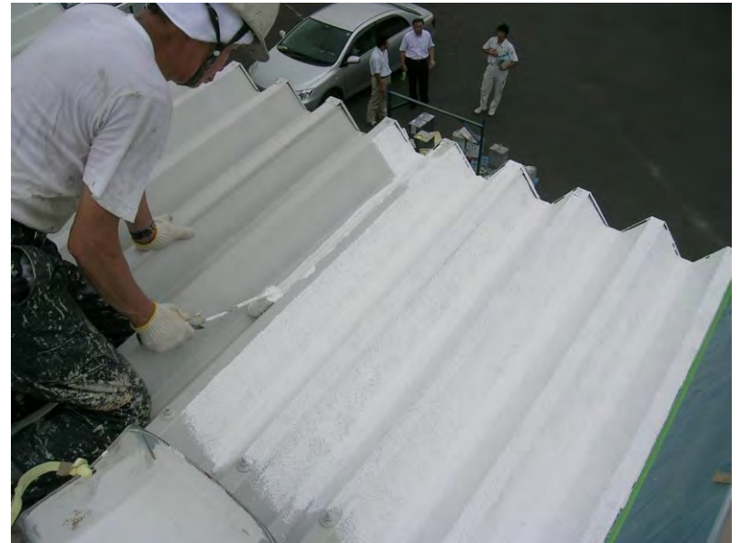
ローラー塗り (多孔質ローラー)
