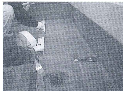
ガラスクロステープにゴムエースLCを含浸させ、接合部を補強する
