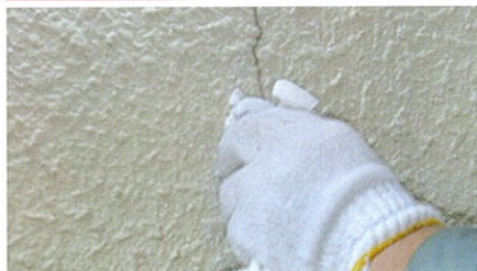
■注入充填後、ふきとり清掃仕上げ
