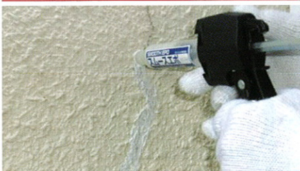
■ひび割れ注入作業(ハンドスモーター使用)
