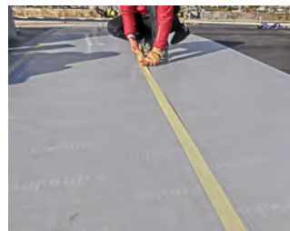
▲ジョイントテープの施工
