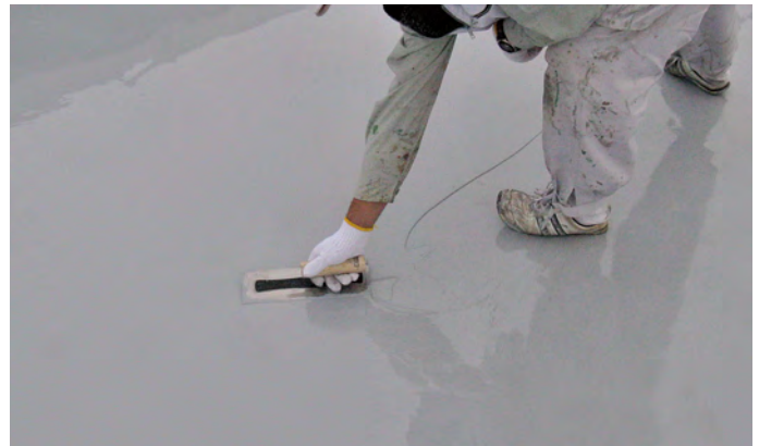
防水材の施工(2層目)
