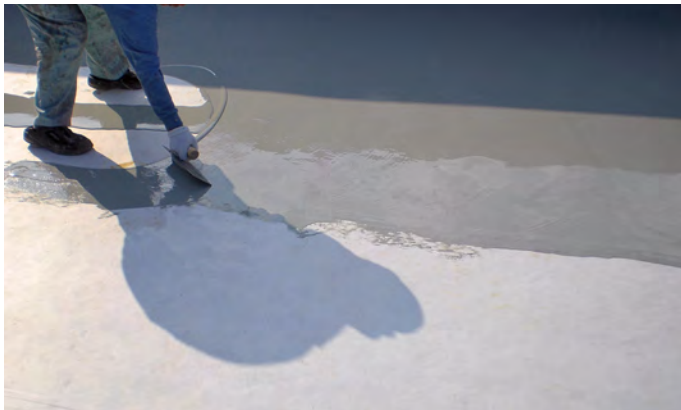
防水材の施工(1層目)
