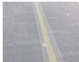
▲補強テープの張り付け
