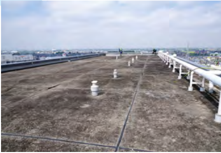
屋上防水改修施工前
