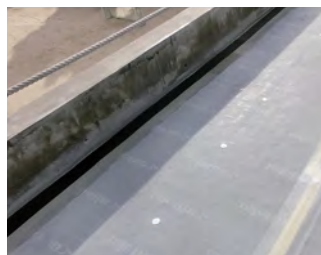
▲端末テープの張り付け
