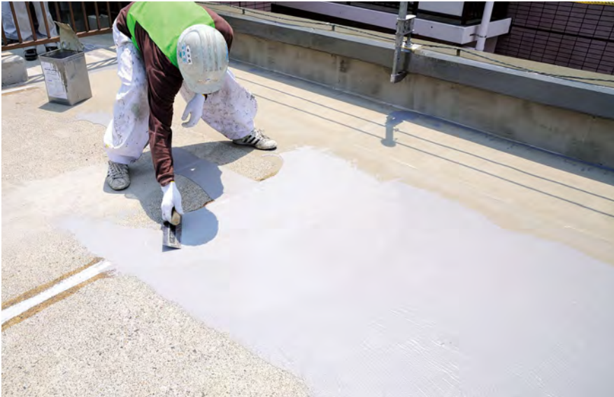
下地処理では必要に応じ、NTカチオンシリーズなどで下地処理を行ってください。
