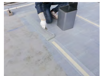
▲メカニカルアンカー座金頭、補強テープのシール処理(ローラー、刷毛)
