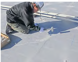
▲メカニカルアンカーの打ち込み
