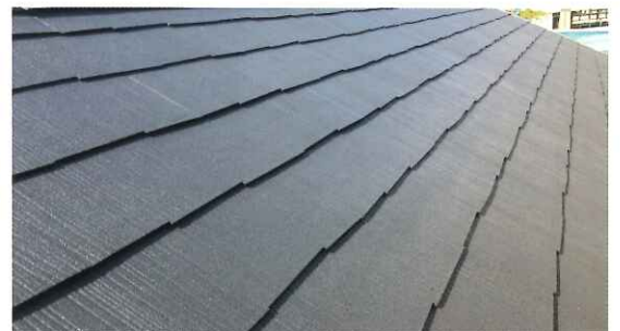
水系ナノシリコン -RN 施工後
