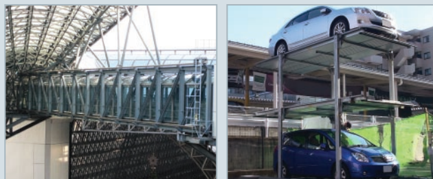
駅ビル渡り廊下
