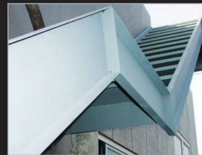
ローバル塗装事例(鉄骨階段)
