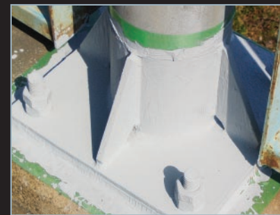
ローバル塗装事例(照明柱土台)
