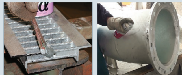
切断面、溶接部
