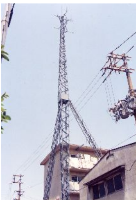
レーダー鉄塔
