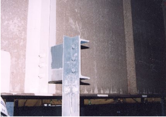
ボルト部補修
