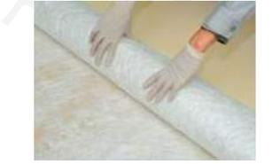
**9** 3時間以上24時間以内(23℃)にタフシール50にパーメックを1~2%混合しFRPローラーでガラスマットに含ませます。(0.8kg/m<sup>2</sup>)
