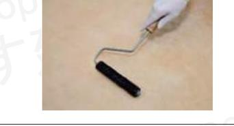
**11** 3時間以上24時間以内にタフシール50にトナーを5%パーメック1~2%混合しFRPローラーで塗りのばします。(0.8kg/m<sup>2</sup>)
