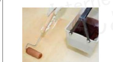
**7** 3時間以上24時間以内(23℃)にもう一度タフシール50にパーメックを1~2%混合しFRPローラーで塗りのばします。(0.8kg/m<sup>2</sup>)
