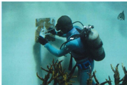
水族館水槽内防水塗装補修施工例
