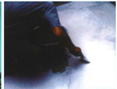
受水槽内の補修施工例
