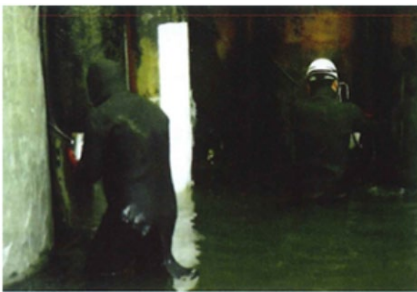
鋼管杭 防食補修施工例
